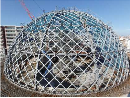
写真1 DI式スペースネット工法の実例
