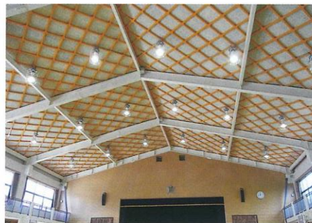
DI式スペースネット工法による施工例
