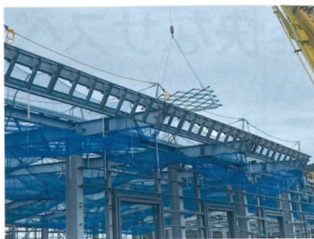
鉄骨建方状況
