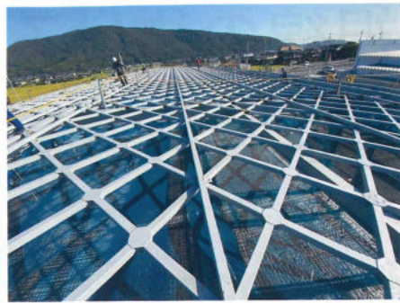
屋根の施工状況
