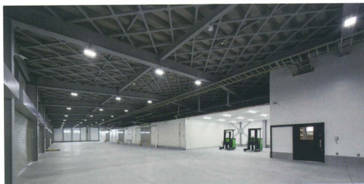
天井の施工状況
