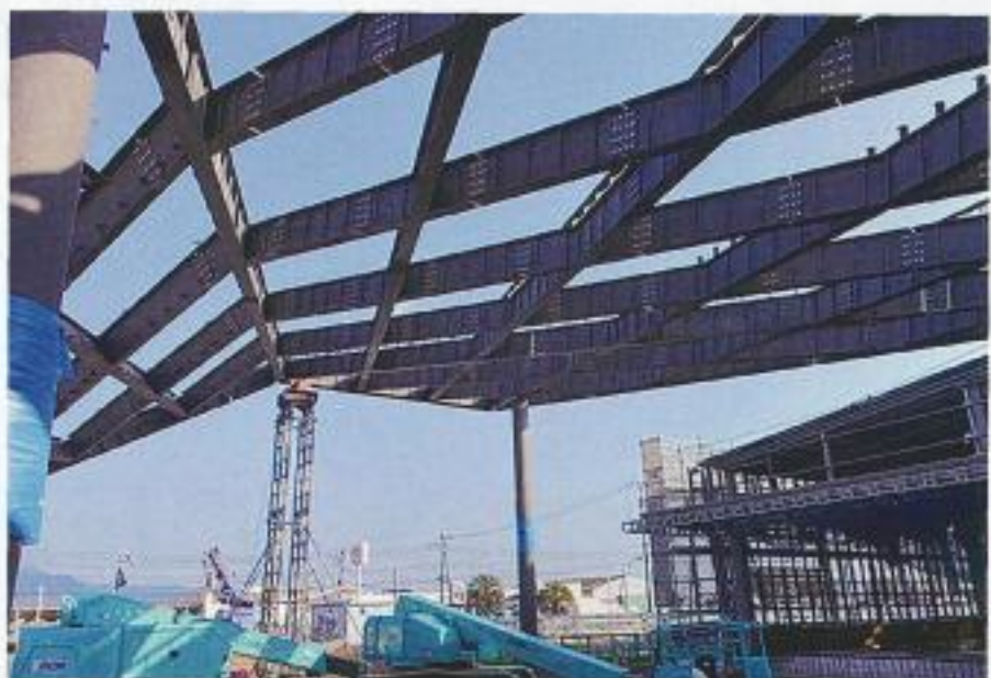
写真4 BIMモデル活用による現場施工
