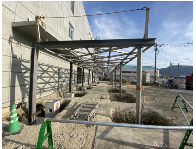
※写真は現在工事中の福岡市内の建物の駐車場部分の工事になります。
