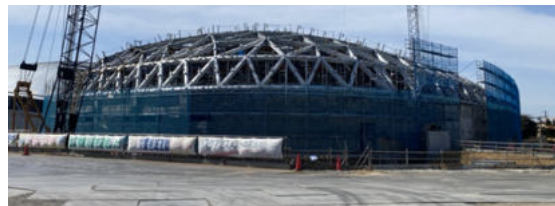
4月20日の様子 本体鉄骨の上に母屋鉄骨の工事が進み、 曲面が一目見え!
