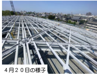
4月20日の様子 本体鉄骨の上に母屋鉄骨の工事が進み、曲面がお目見え！
