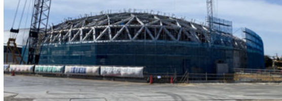
4月20日の様子 本体鉄骨の上に母屋鉄骨の工事が進み、曲面がお目見え！
