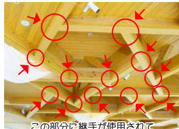
この部分に継手を使用して木材の大屋根を実現しました
